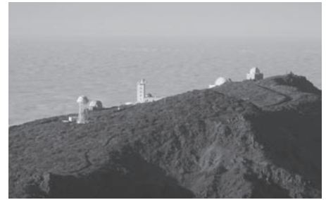
Obr. C2: Část observatoře Roque de los Muchachos, La Palma, Kanárské ostrovy. První zleva je holandský sluneční dalekohled DOT o průměru 45 cm, třetí zleva je metrový švédský refraktor SST vybavený adaptivní optikou. Ostatní přístroje slouží k nočnímu pozorování.
